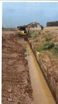
ภาพที่ 36 ขุดลอกตะกอนดิน
